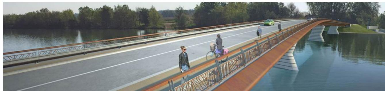
Le nouvel ouvrage d'une longueur totale de 272 m, réparti en quatre travées, a été conçu pour limiter l'entretien ultérieur. D'une largeur de 12 m, il supportera deux voies routières de 3,50 m, un trottoir de 3 m pour les modes de doux, qui reliera la voie bleue en Saône-et-Loire et le chemin de halage du canal de Pont-de-Vaux, et un trottoir de service de 1 m.
